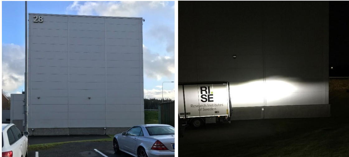
Figur 4. Till vänster högspänningshallens norra vägg i dagsljus. Till höger ljusbilden från en Volvo V40:s helljus.
