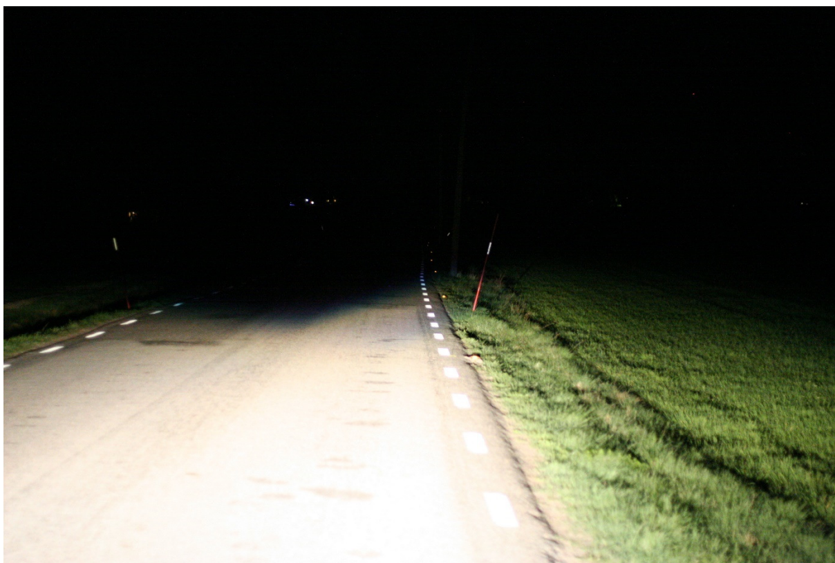
Figur 17. Sträcka 5 med reflektorer placerade längs kantlinjen (notera att fotografen står upp till höger om fordonet, dvs bilden motsvarar inte riktigt hur föraren ser vägen och kantlinjen).
