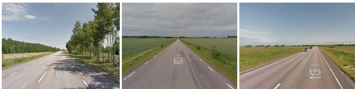
Figur 2. De tre försökssträckorna. Vänster: väg 1050, mitten: väg 1025, höger: väg 1136. Bilden på väg 1136 är tagen innan vägen fick ny beläggning och nya vägmarkeringar. Bilder: Google Maps.
