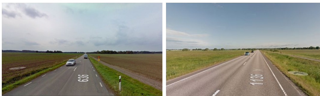
Figur 4. De två försökssträckorna. Vänster: väg 636, höger: väg 1136. Bilden på väg 1136 är tagen innan vägen fick ny beläggning och nya vägmarkeringar. Bilder: Google Maps.
