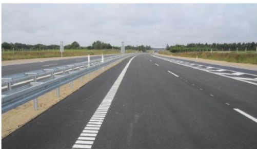
Figur 4.7 Indre kantbane på motorvej i 1,5 meters bredde (foto fra strækningen Bording-Funder på rute 15).
