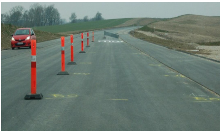
Figur 4.15: Hvidt hastighedssymbol (med tallet 110) med symbolhøjde 9,0 meter og smal hvid ring.
