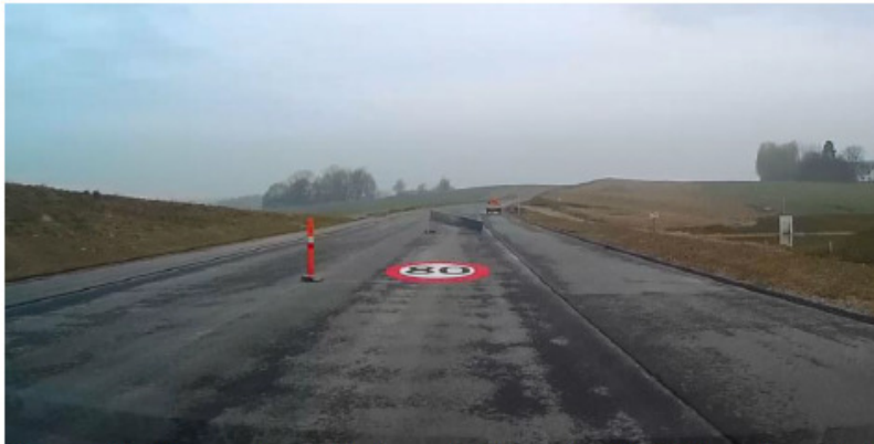
Figur 4.3: Farvet hastighedssymbol (med tallet 80) med symbolhøjden 5,0 meter
