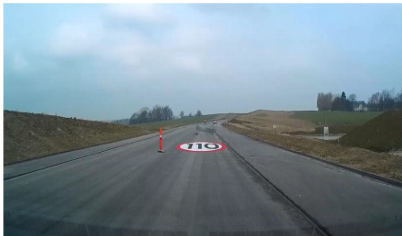
Figur 4.7: Farvet hastighedssymbol (med tallet 110) designet med smal rød ring og symbolhøjde 9,0 m.
