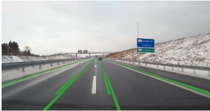
Figur 3.3: Grønne myldretidslinjer udført som kombinerede vognbanelinjer/spærrelinjer, der muliggør sporskifte mod højre til frakørsel.
