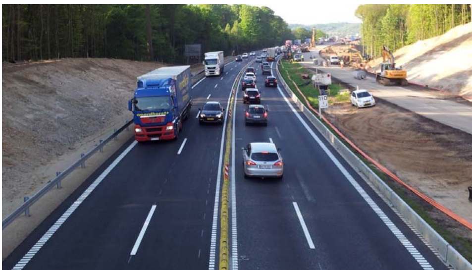
Figur 6.4 Eksempel på etablering af midlertidig midtaeradskillelse i forbindelse med vejarbejder.
