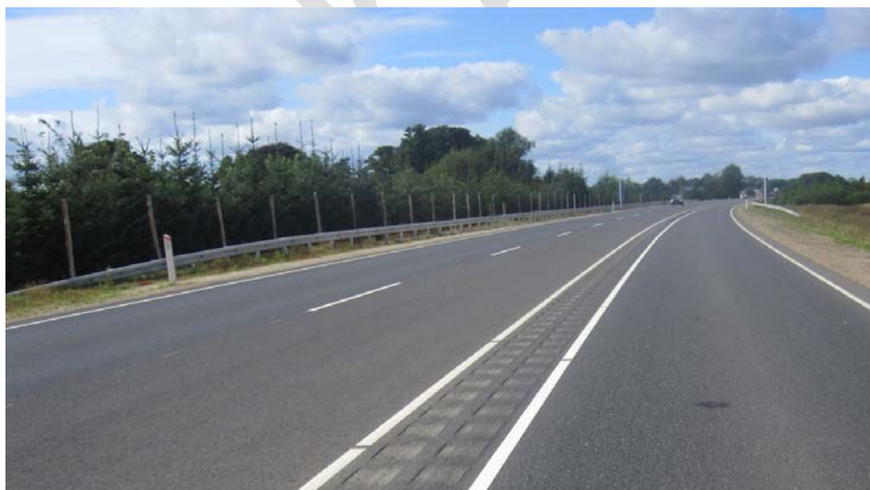
Figur 4.6 Rumleriller langs midtlinje på 2+1 vej (foto fra strækningen Bredsten-Vandel på rute 28).
