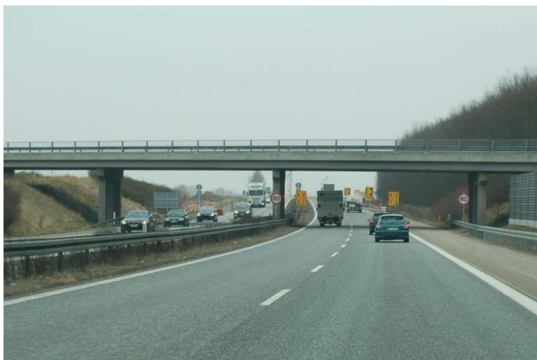
Foto 1. Ca. 200 m før rumlestriberne.
