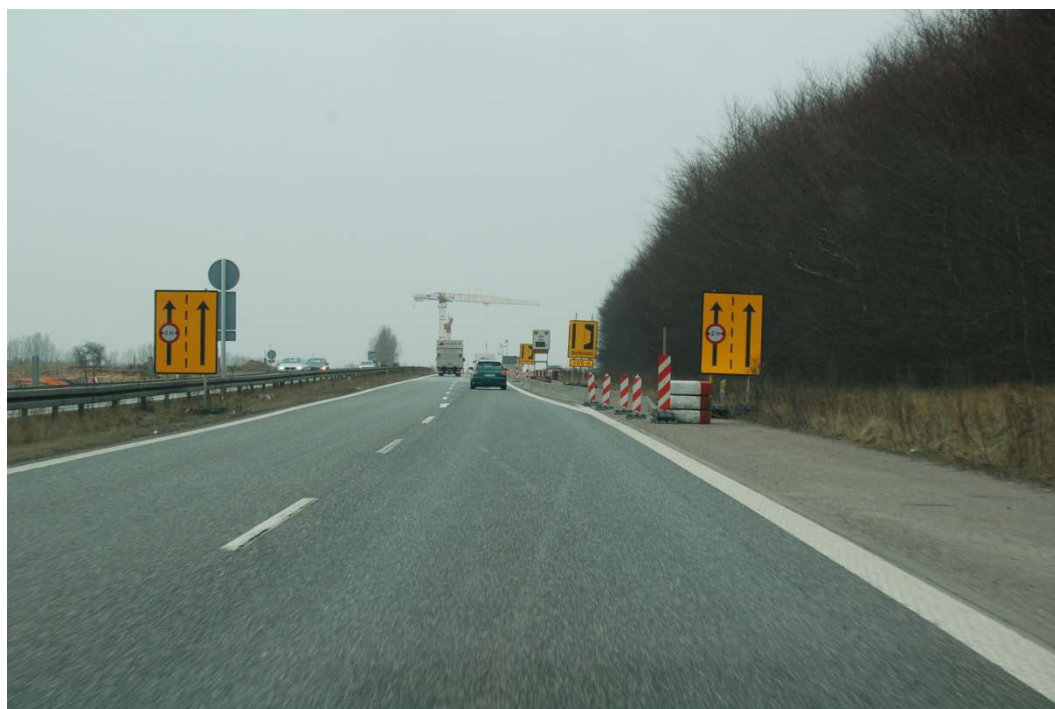
Foto 2. Ca. 100 m før rumlestriberne
