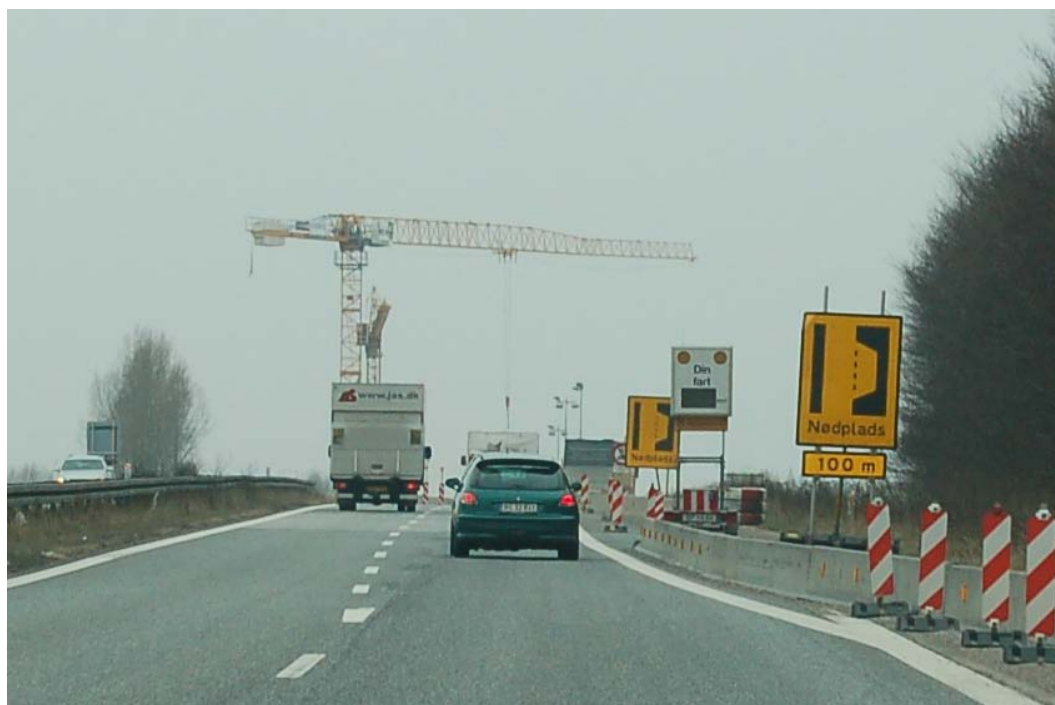
Foto 3 Ca. 50 m før rumlestriberne.
