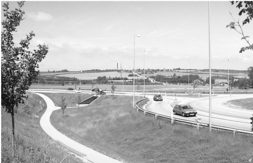
Figur 5.17 Eksempel på krydsning i to planer mellem cykelsti og vej i en rundkørsel.
