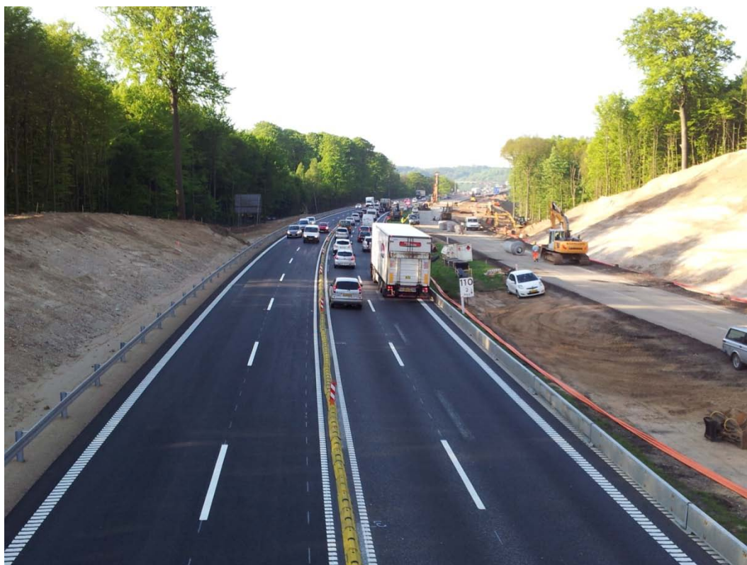
Foto 3. Foto taget i retning mod syd 21. maj 2012. Der er opsat midlertidigt autoværn i køreretning mod syd, og der er ikke længere to sæt profilerede striber i køreretning mod syd.
