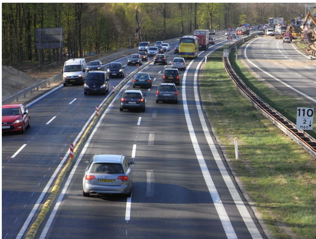
Foto 2. Foto taget i retning mod syd 2. maj 2012. På dette tidspunkt var der ikke opsat midlertidigt autoværn i køreretning mod syd. Der er i køreretning mod syd to profilerede striber.
