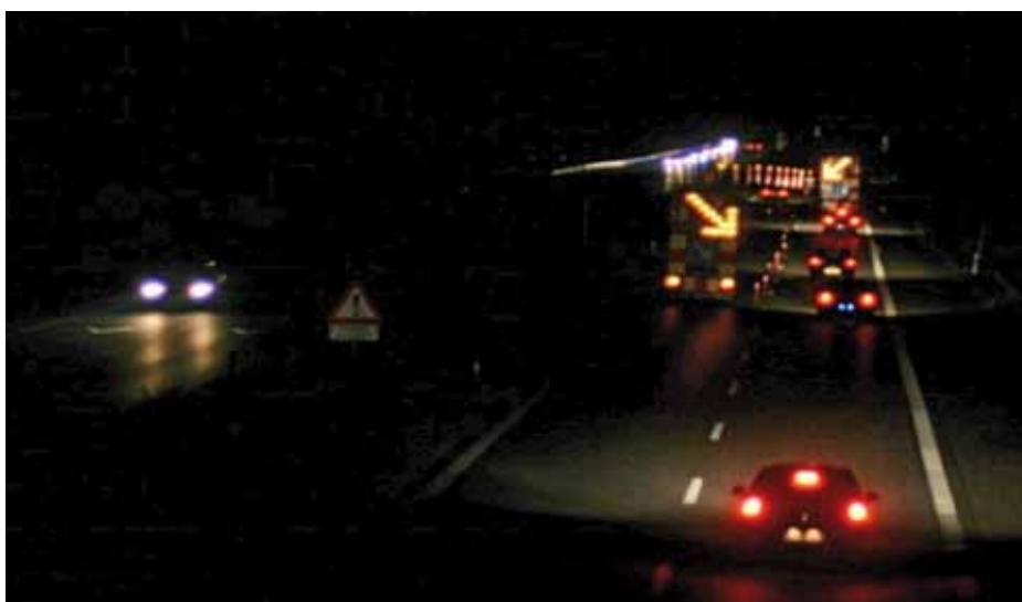
Figur 1. Afmærkning af vejarbejde med trafikoverledning på motorvej i mørke.
