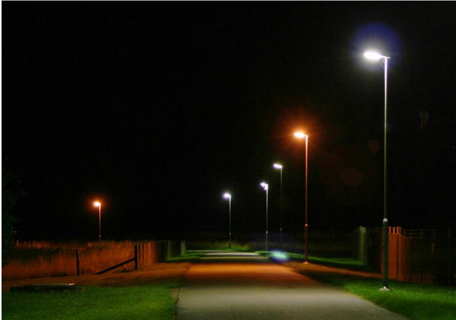
Figur 6 Vitt ljus ger bättre färgåtergivning och kan även uppfattas som mer uniformt än gulorange ljus.
