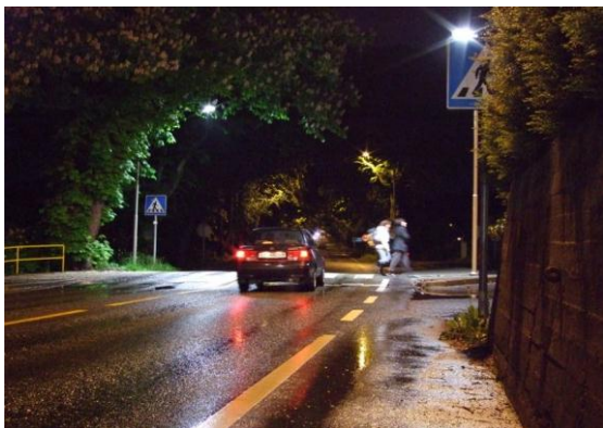
Figur 2: Intensivbelyst gangfelt i Porsgrunn
