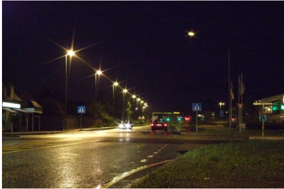
Figur 4: Forsterket belysning i kryss med gangfelt
