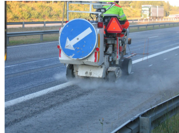
Fräsning av räfflor på rv 4 i Uleåborg
