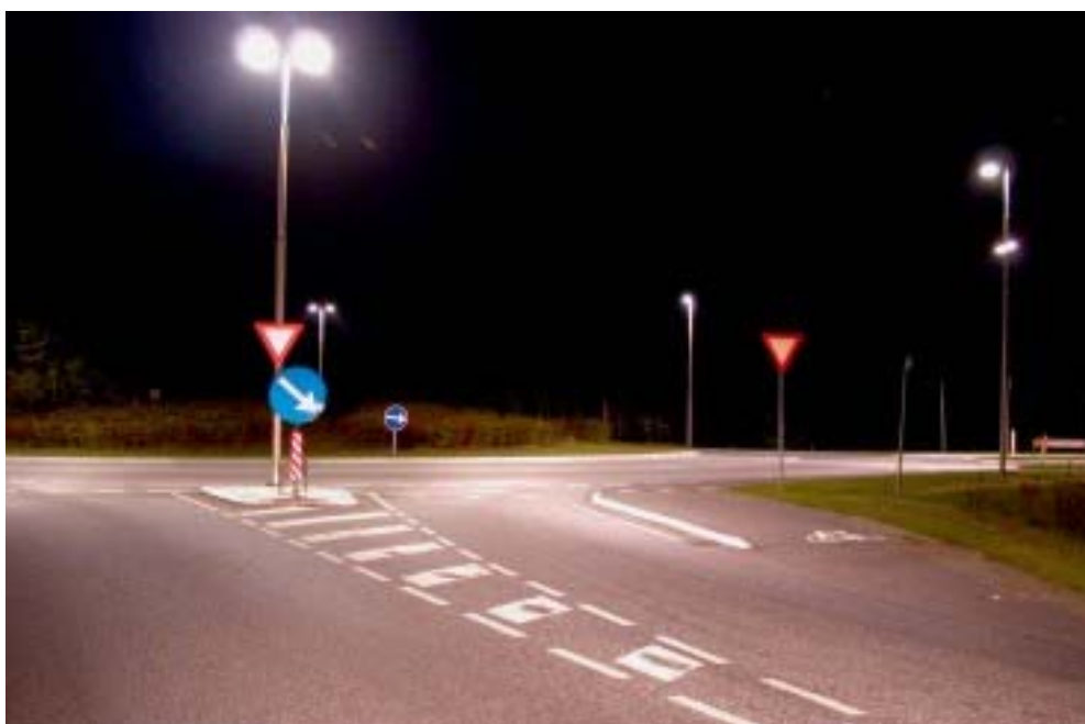
Figur 2: Typisk afmærkning ved tilkørsel til en rundkørsel.
