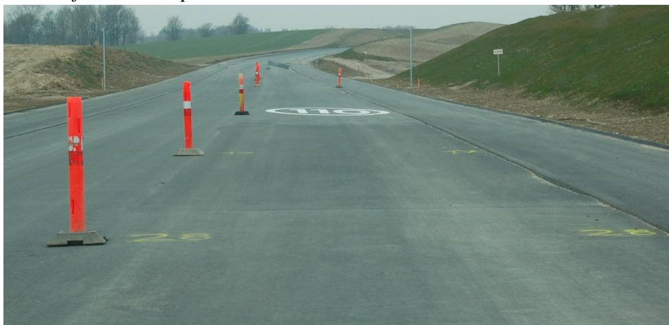
Figur 4.13: Hvidt hastighedssymbol (vist med tallet 110) med symbolhøjde på 7,0 meter.
