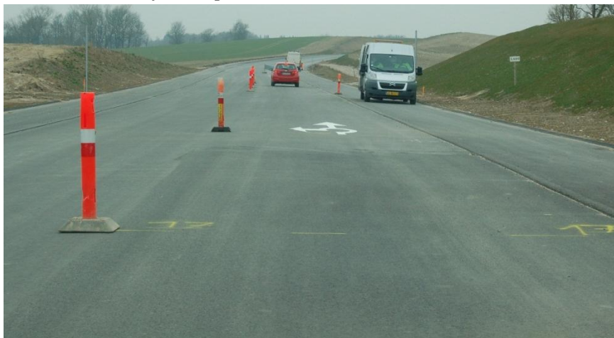
Figur 4.17: Rundkørselspil efter hollandsk design med symbolhøjde på 6,8 meter.
