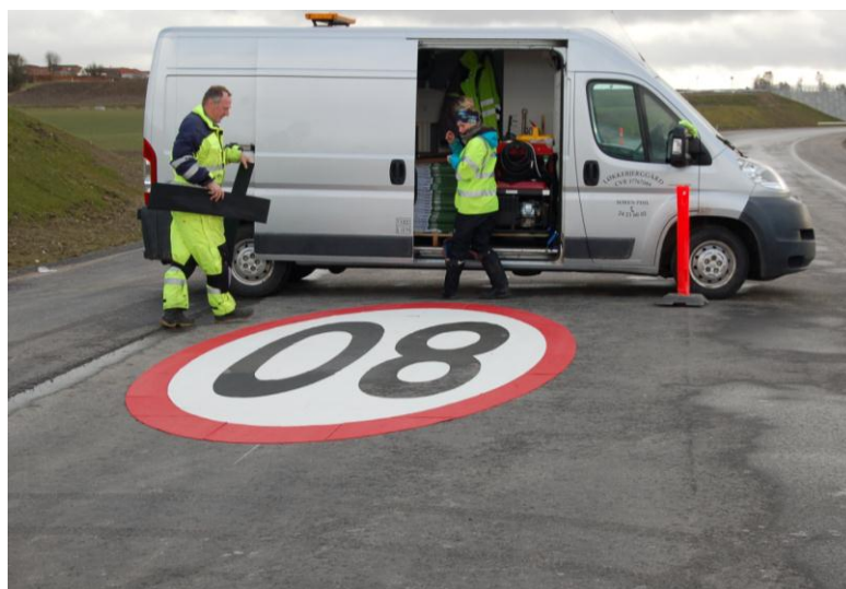
Figur 2.2: Udlægning af symbolet i premark.
