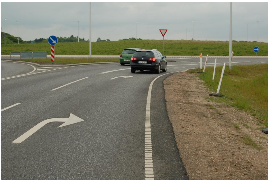
F6: Tilfarternes tilslutning til cirkulationsarealet er designet som en højrecurve.
