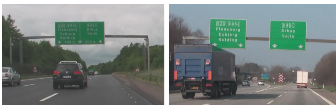
Figur 4: Portaltavler med angivelse af hvor vognbanerne fører hen. Til venstre portaltavlen 500 meter før forgreningen, til højre portaltavlen i divergenspunktet.
