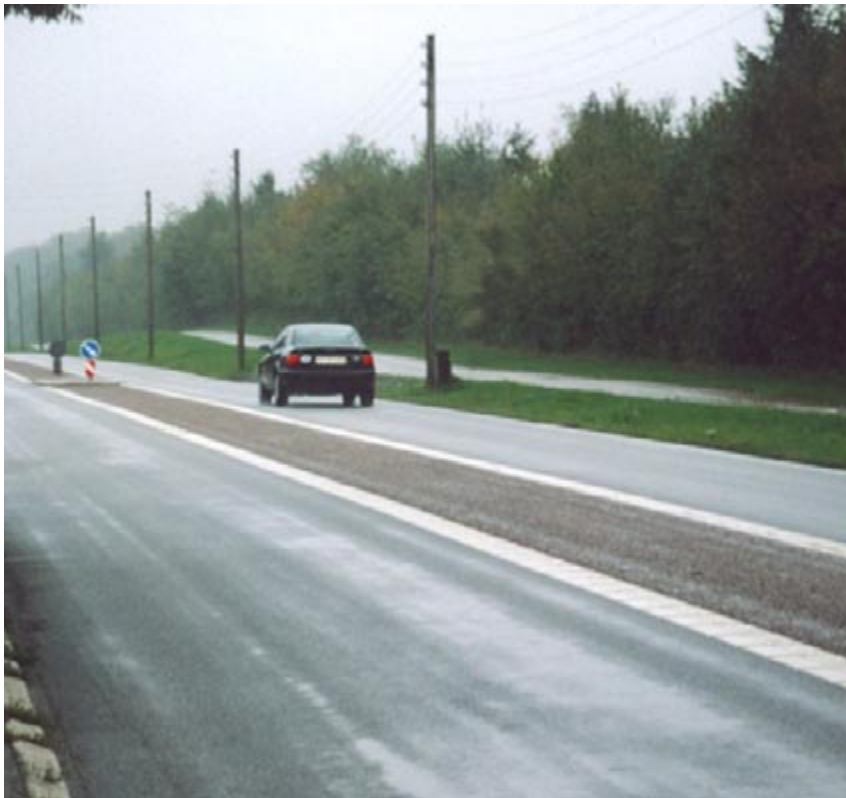
Midterareal med ru belægning.
