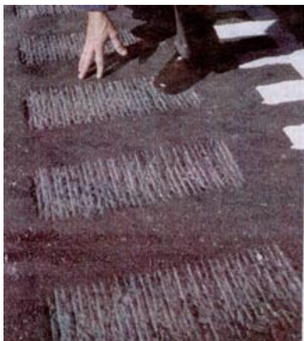
Eksempel på nedfræsning i asfalt.
