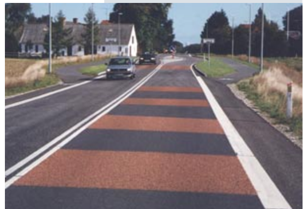
Den farvede og ru belægning giver både lyd og visuel effekt. (Foto: Bent Pødenphant)
