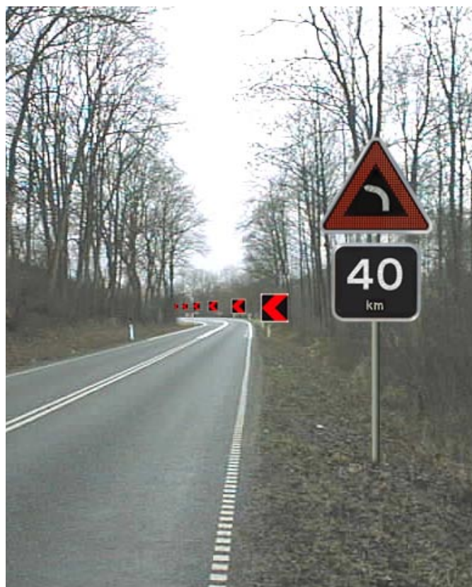
8 Baggrundsafmærkning med dioder og dynamisk tavle.
