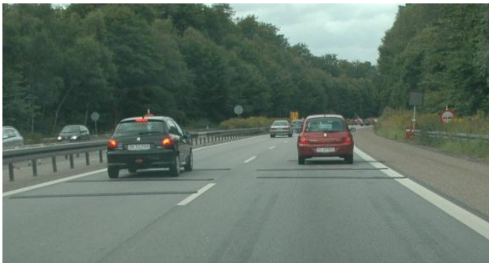
Foto 3.14: Den elektroniske tavle med budskabet SÆNK FARTEN er her placeret EFTER rumlestriberne på strækning med skiltet 70 km/t. Den aktiveres kun når hastigheden er for høj.
