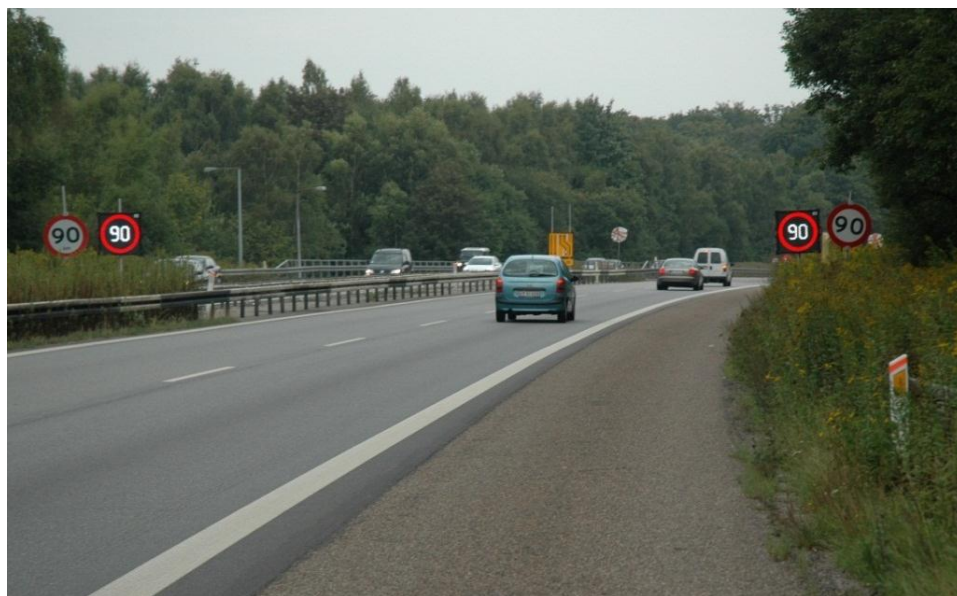
Foto 3.18: Den faste C55 tavle 90 km/t er suppleret med en VMS tavle.
