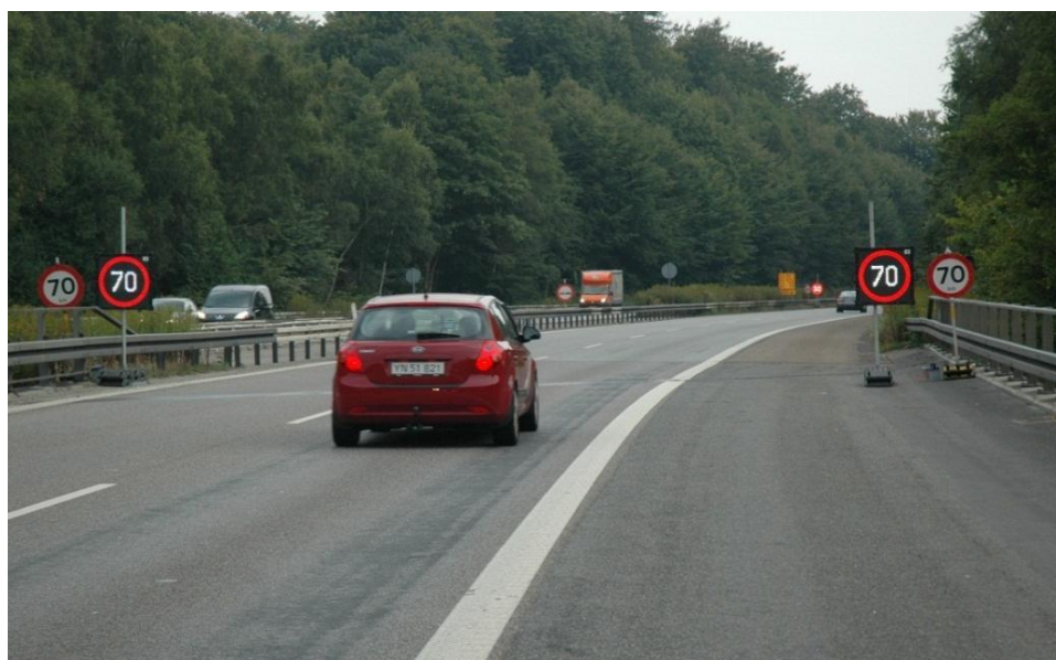
Foto 3.19: Den faste C55 tavle 70 km/t er suppleret med en VMS tavle.
