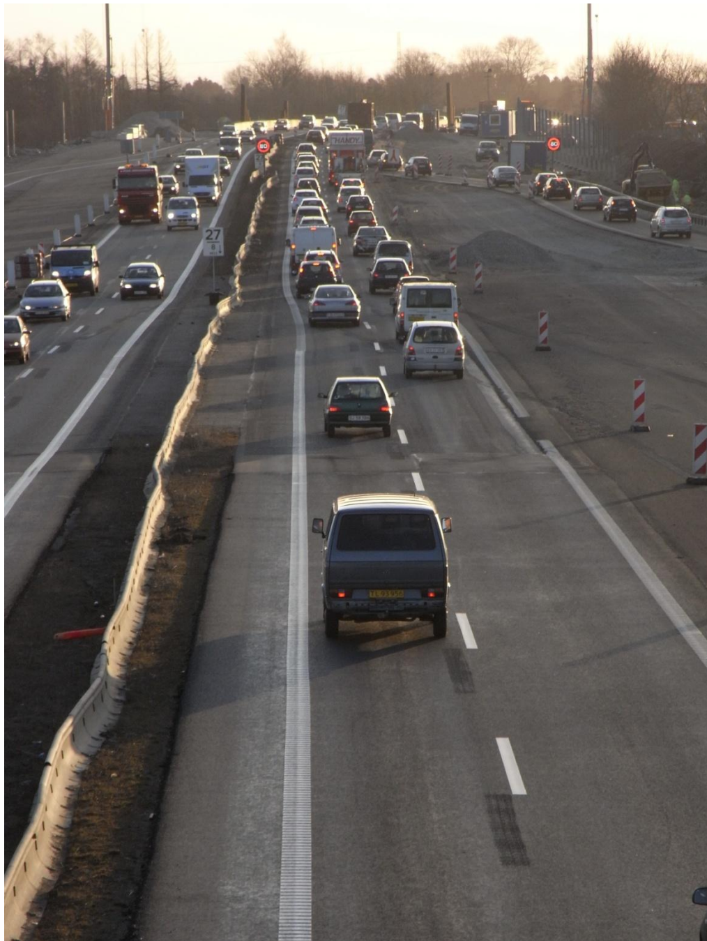
Strækningen på Holbækmotorvejen.
