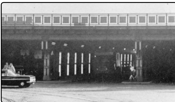
Figure 6: Tunnel representing lighting class 3b: vertical tubular lamps form a bright background (Source: Nederlandse Stichting voor Verlichtingskunde (NSVV). 'Aanbevelingen voor tunnelverlichting'. Electro-Techniek , Vol 41, No 2 (1963) p47.)
