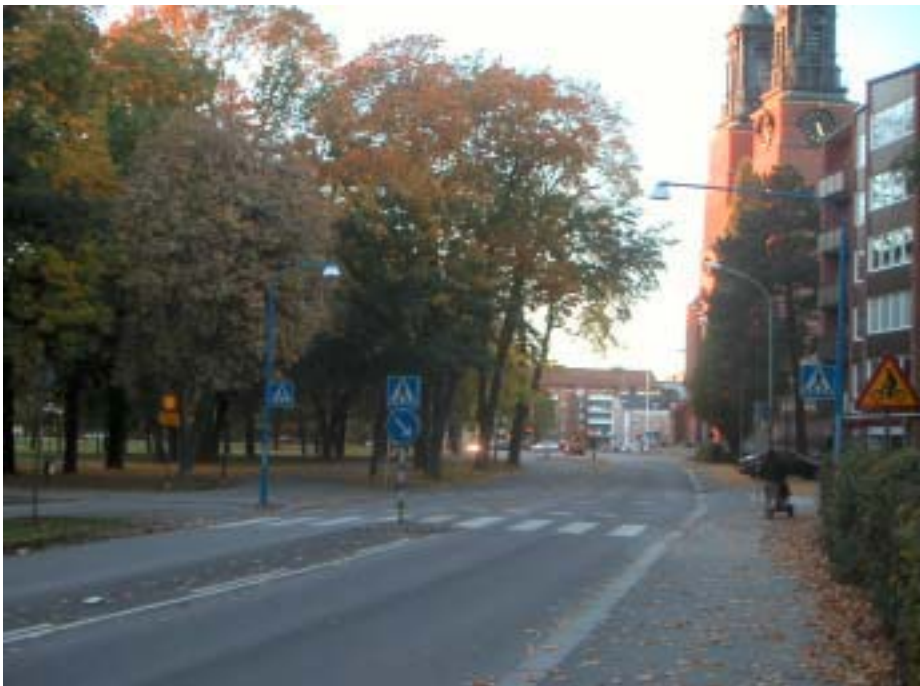
Figur 2 Strandgatan vid korsningen med Törnerosgatan med den studerade g/c-överfarten med två uppsatta belysningsarmaturer. I korsningens bortre del finns en cykelöverfart över Strandgatan. Foto: VTI
