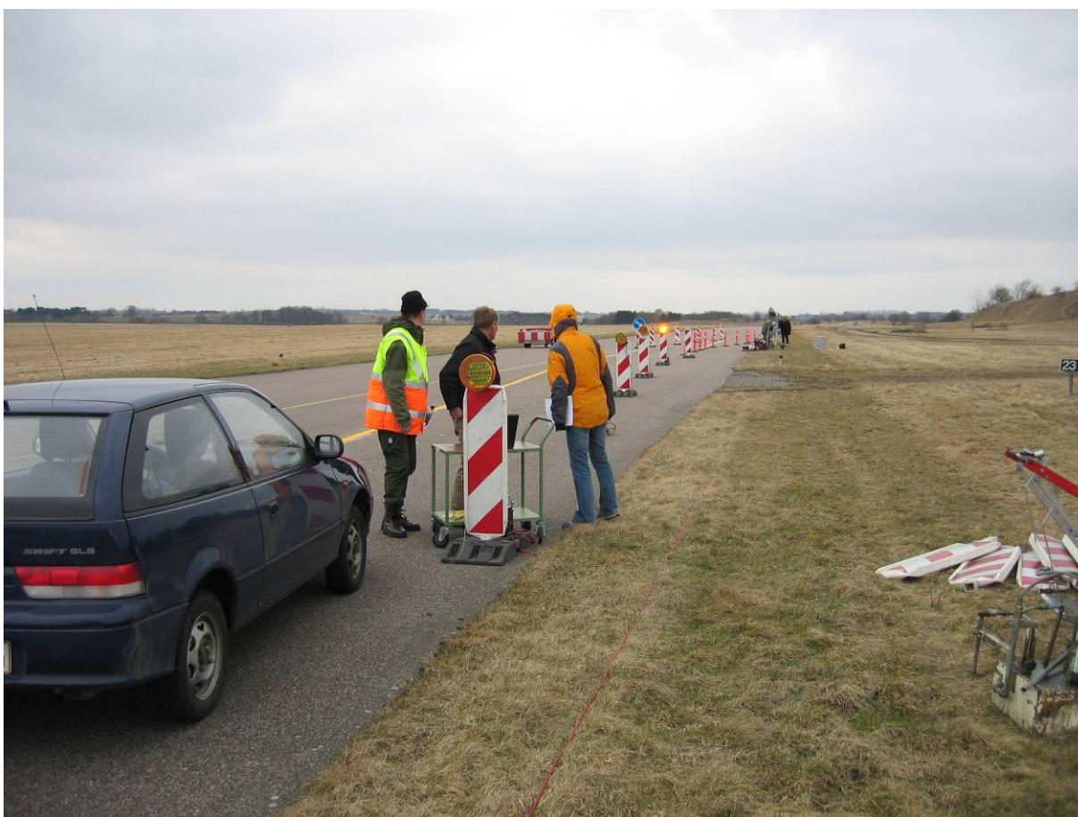
Figur 3.1 Uppställning av vägarbetsplats på Værløse flygfält.
