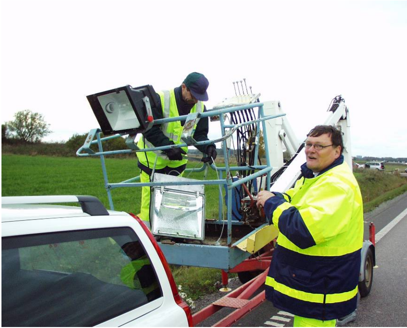
Figur 4.2 Montering av arbetsplatsbelysning på skyliften.
