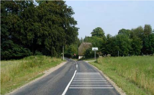
Figur 1: Forhøjede rumlestriber udført i termoplast
