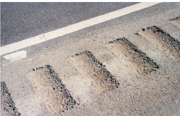
Figur 3: Nedfræsede rumlestriber (ref. 8) skæres ud i den eksisterende vejbelægning ved brug af en roterende tromle forsynet med skærehoved.
