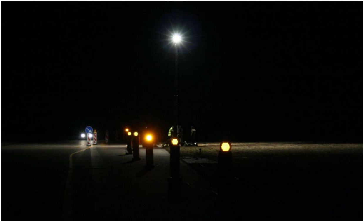
Figur 4. Prøvesituasjon med tre 1000 W symmetriske halogenlyskastere av fabrikat Cariboni montert i masta
