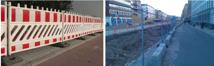
Figur 6-62. Eksempel på anvendelse af afspærringshegn til længdeafspærring
