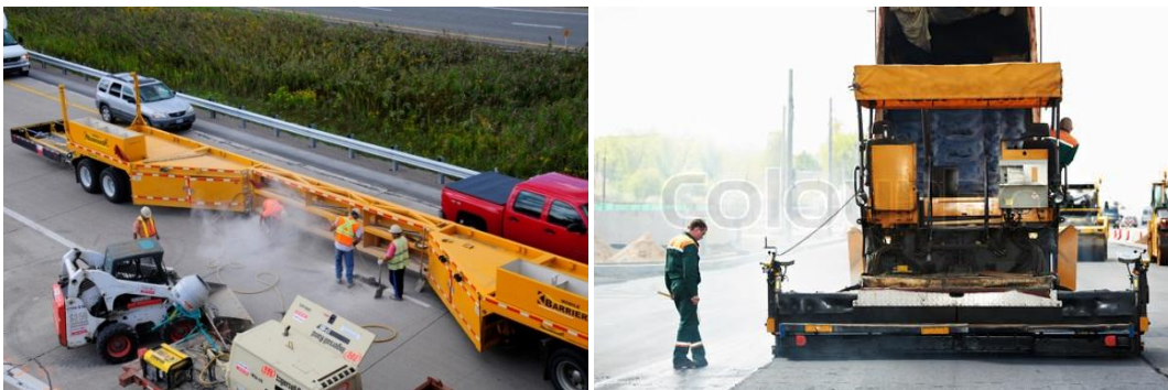
Figur 6-52. Eksempler på beskyttelsesmoduler (mobile-work-zone-barrier og asfaltudlægger)
