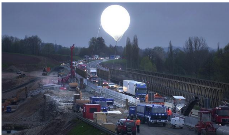
Figur 2-2. Eksempel på arbejdspladsbelysning, som ikke giver generende blænding eller reflekser
