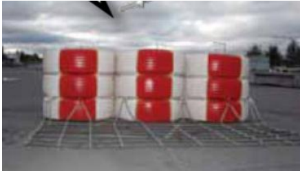
Figur 6-51. Eksempel på energiabsorberende tværafspærring (trafikbuffert)
