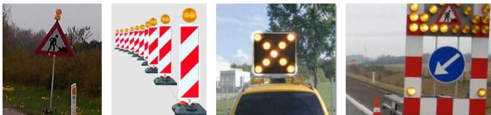
Figur 6-36. Eksempler på anvendelse af Z 93 Gult blinksignal
