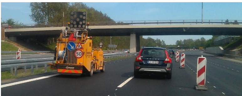
Figur 5-2. Eksempel på afstribning med maskine
