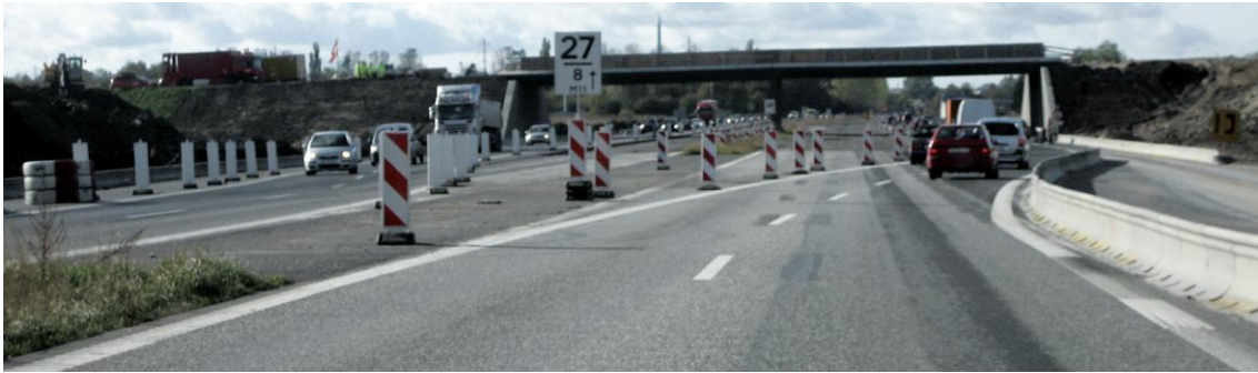
Figur 3-13. Eksempel på dynamisk forsætning med N 42 og afstribede s-kurver
