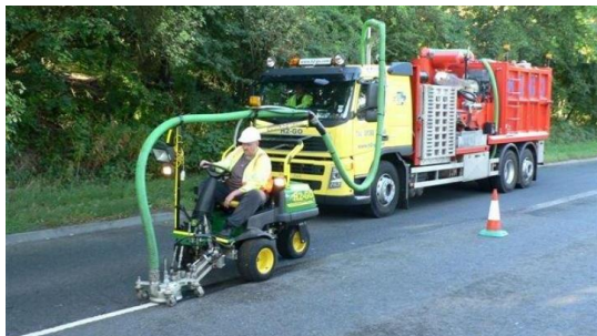
Figur 6-33. Eksempel på metode til skånsom fjernelse af afmærkning
