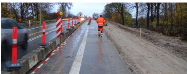
Figur 6-73. Eksempel på længdeafspærring med betonklodser og kantafmærkning
