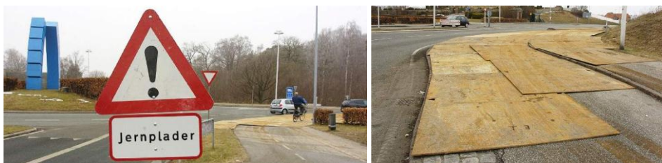
Figur 6-74. Eksempler på køreplader og afmærkning heraf
