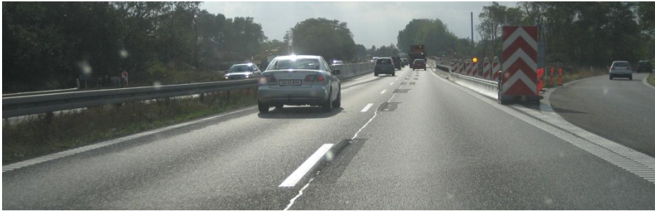
Figur 6-34. Eksempel på belægning med ar efter fjernet afmærkning
