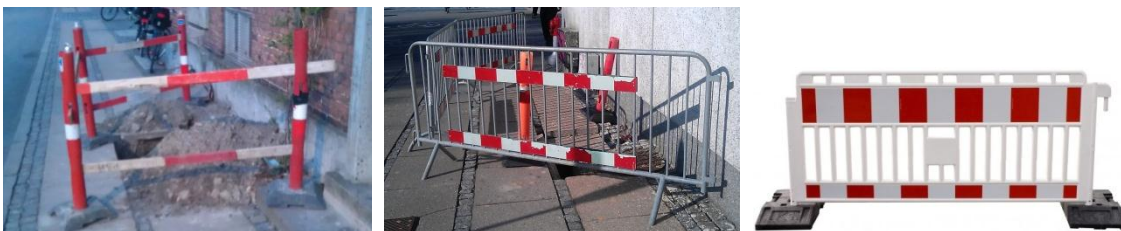
Figur 3-4. Eksempler på tværafspærring på fortov
