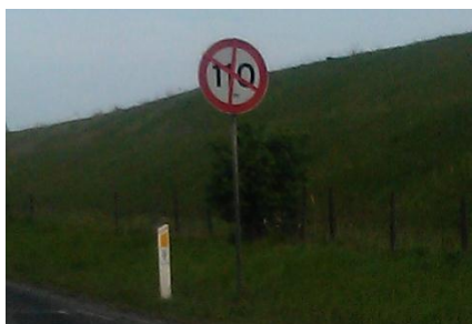
Figur 3-18. Eksempel på overstregning af færdselstavle
