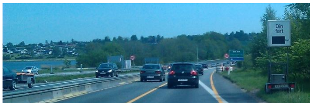
Figur 6-23. Eksempel på mobil fartviser ved vejarbejde
