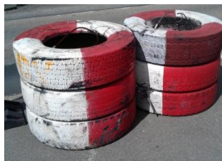
Figur 6-50. Eksempel på energiabsorberende dæksøjler til sikring af trafikværsender.
