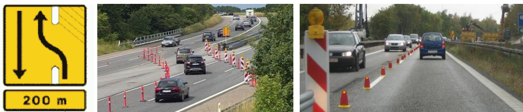
Figur 3-22. Eksempler på afmærkning af overledninger
