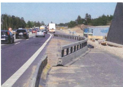
Figur 6-46. Eksempel på trafikværn med manglende forankring, overlap eller overgangsstykker mellem trafikværn
