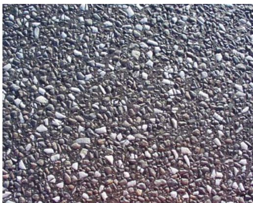
Figur 9 Skelettasfalt med stenstorlek 16 mm.
