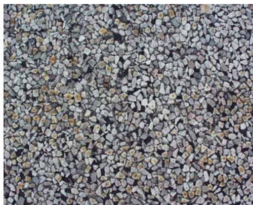
Figur 13 Ytbehandling Y1B med stenstorleken 12 mm.
