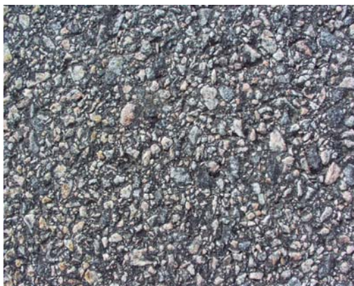
Figur 15 Tät asfaltbetong med stenstorleken 16 mm.
