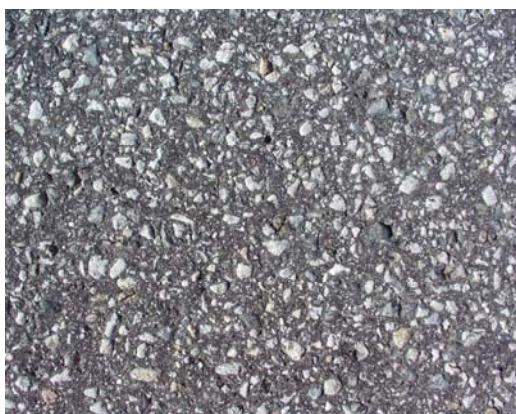
Figur 11 Mjuk asfaltbetong med stenstorlek 11 mm.
