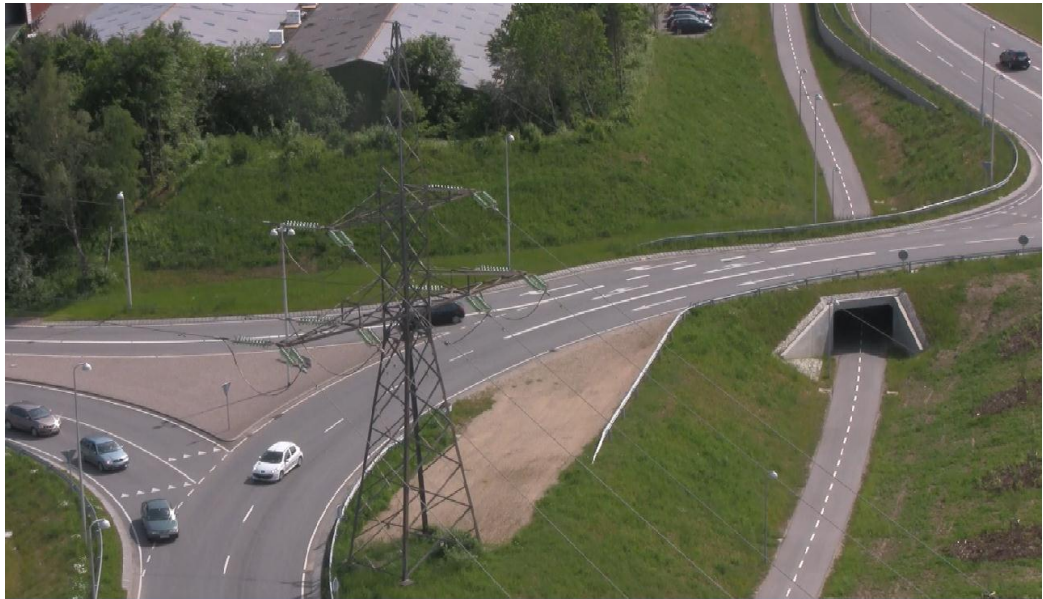
Figur 3. Konfliktende adfærd mellem en indkørende trafikant fra Ny Esbjergvej og en cirkulerende trafikant, der på samme tid skifter fra det venstre til det højre cirkulationsspør. Den cirkulerende trafikant bremses for den indkørende, og kører herefter ud af rundkørslen ved Birkedam.
