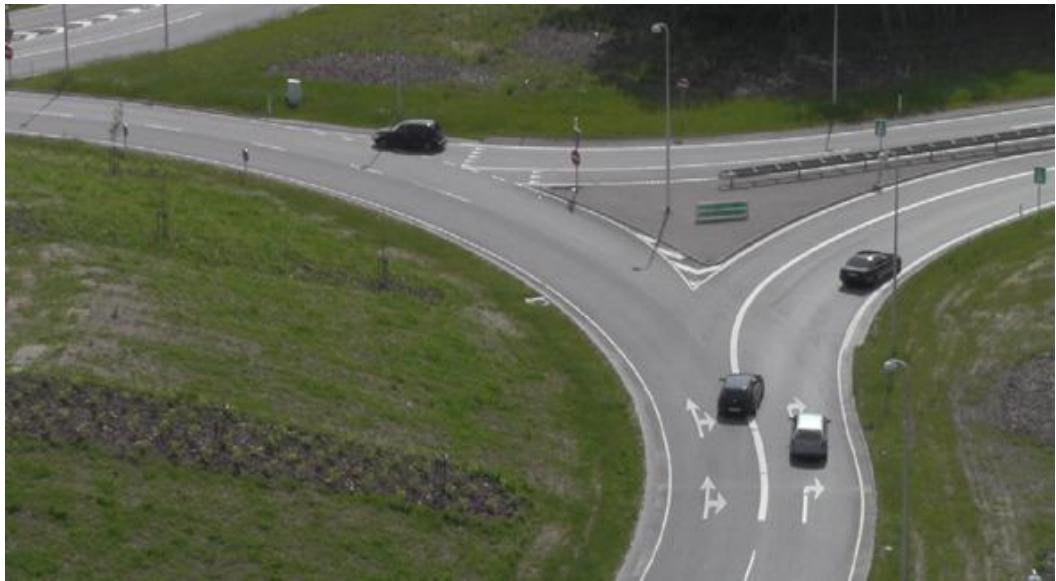
Figur 7. Til- og frafart ved motorvejen i retning mod Esbjerg/Flensborg. Mange bilister foretager tæt på frakørslen et unødvendigt vognbaneskift mod højre for at komme ind i det højre frafartsspor. Dette skyldes formentligt en kombination af at det venstre frafartsspor er smalt, og at det giver et mere køredynamisk forløb ud af rundkørslen.
