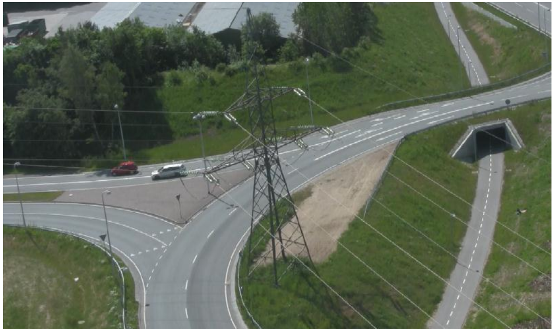
Figur 2. Ny Esbjergvej. Der er to til- og frafartsspor på Ny Esbjergvej. Hovedparten af udkørende benytter det højre frafartsspor, hvilket formentligt skyldes at det venstre frafartsspor er forholdsvis smalt.
