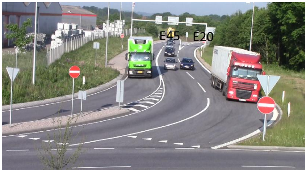
Figur 10. Tilfartsspor hvor trafikken fra E45 og E20 føres ind i hhv. det højre og det venstre tilfartsspor ca. 135 m før vigelinien. Højresvingsshunten føres ned ad Stålvej, og kan kun benyttes af de trafikanter der kommer ind i det højre tilfartsspor fra (E45). På foto ses en konflikt mellem en trafikant der vil foretage vognbaneskiift fra det venstre til det højre tilfartsspor, men som må bremse og ændre sideværtsplacering for at lade trafikanten i det højre tilfartsspor køre først.
