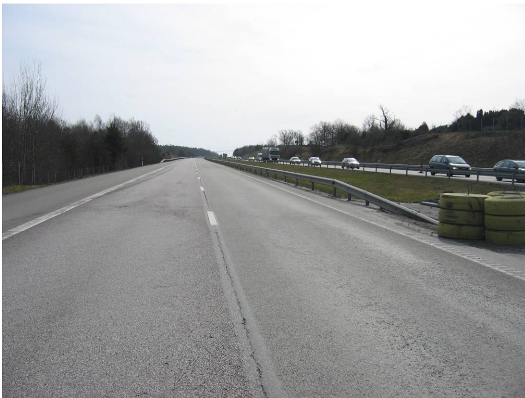
Figur 3.1 Foto på den avstängda delen av E6 där fältförsöken genomfördes.
