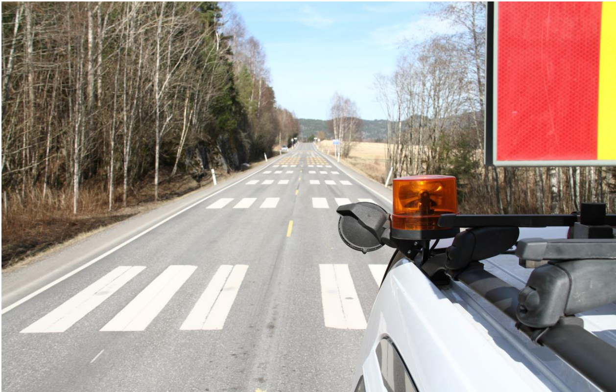
Cleanosol. System 4 nærmest.
