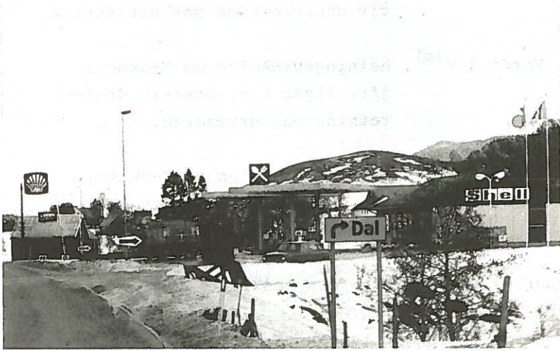
Figur 4.12 Bensinstasjon ved E6 syd for Trondheim Petrol station along E6 south of Trondheim
