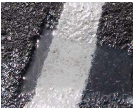
Helningen på veien og fresesporet påvirker hvordan vannet blir liggende i gropene under, måling av våt retrorefleksjon.
