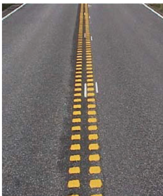
Dobbel sperrelinje på rv. 3, lagt som gul nedfrest longflex i 10:10 kombinasjon.
