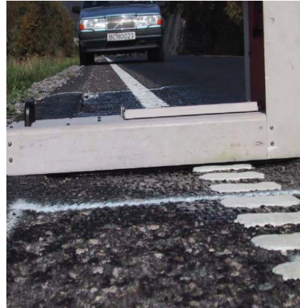
Her ser man hvordan vegmerkingen (longflex) ligger beskyttet i det nedfreste sporet.
