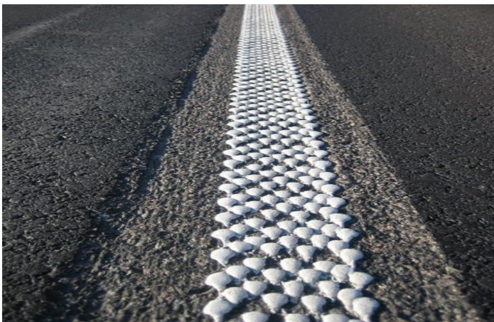
Nedfrest dråpeflex. Eksempel på annet alternativ som er under utprøving og som vil bli evaluert.
