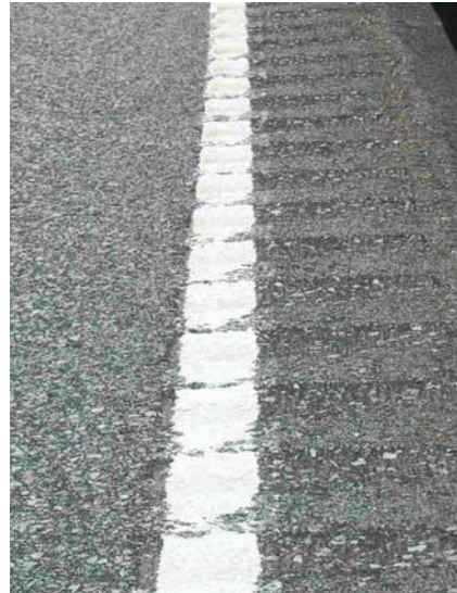
Rumbleflex etter en vinter med høvling og ploging.
