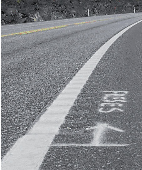
Nylagt rumbleflex på E6 ved Hunderfossen 2002.
