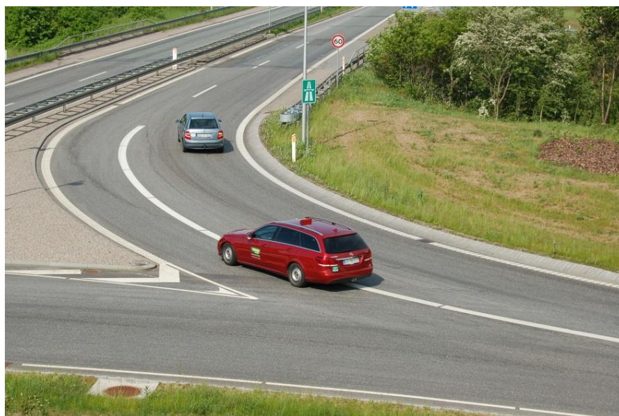
Foto 6.5: De to udkørselsspor i retning mod E20 Esbjerg/E45 Flensborg. En del af trafikanterne der kører ud fra det inderste cirkulationsspor overskrider den fuldtotrukne skillelinje.
