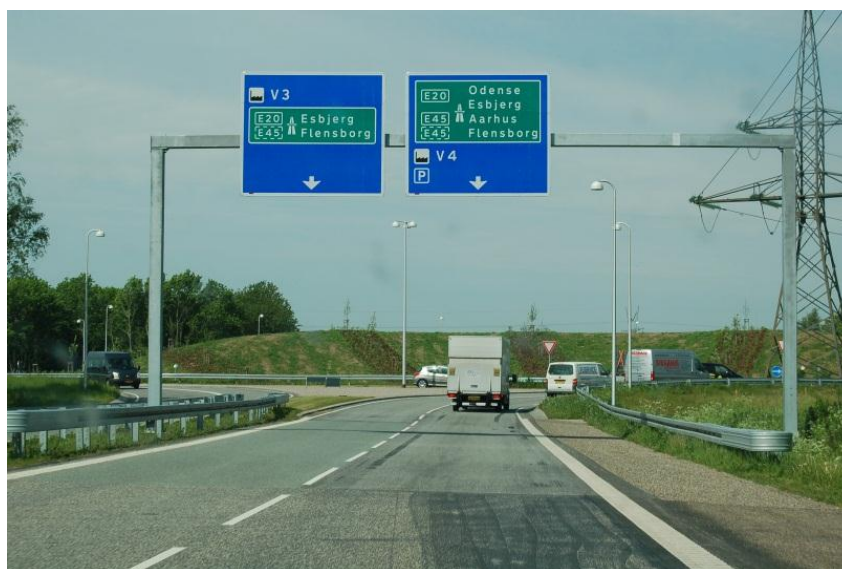
Foto 6.9b: Den tosporede tilfart fra Ny Esbjergvej set ca. 100 meter før rundkørslen. To fysisk adskilte vejvisningstavler – én tavle for hvert spor frem.
