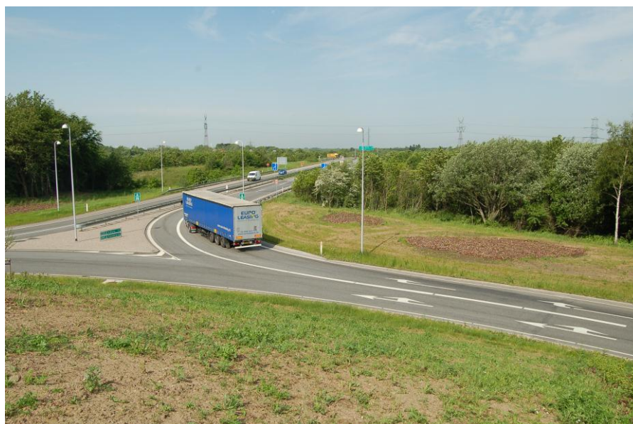
Foto 6.3: De to udkørselsspor i retning mod E20 Esbjerg/E45 Flensborg er adskilt med fuldtoptrukket skillelinje. Det medfører tvunget højresving i det yderste cirkulationsspor og muligt højresving fra det inderste cirkulationsspor. Det højre svingspor er afmærket med større bredde end det venstre spor, for at skabe plads til de store tunge køretøjer.
