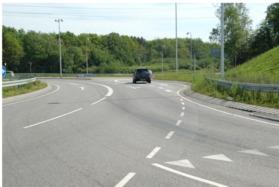
Foto 6.7: Tosporet frafart i retning mod Kolding ad Ny Esbjergvej. Det højre frafartsspor er udformet som et kort tillægsspor. De fleste bilister kører ind i det højre tillægsspor ved udkørsel.
