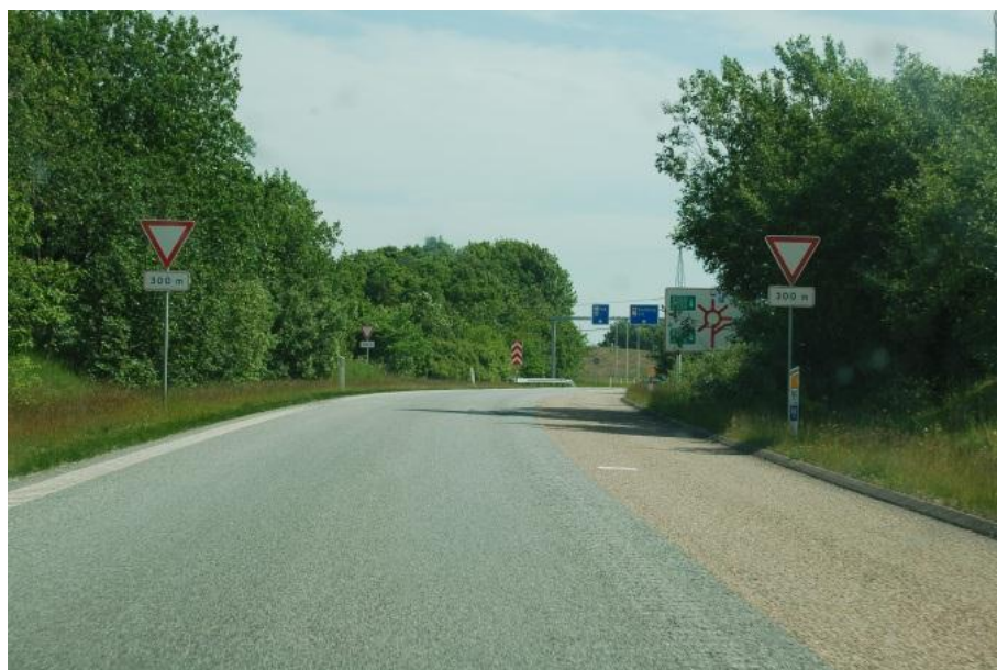
Foto 6.10a: Tilfart ad motorvejsrampe fra sydvest ca. 300 m før rundkørslen
