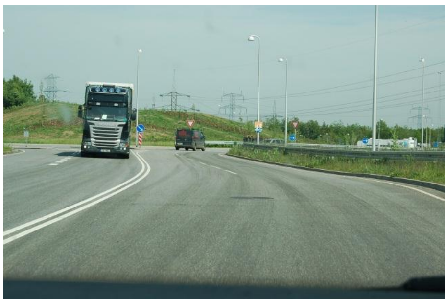
Foto 6.11b: Tilfarten fra Stålvej ca. 90 meter før rundkørslen
