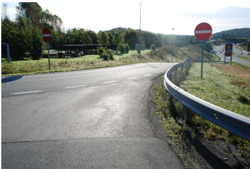
Figur 1.6. Munning av avkjøringsrampe fra sør.
