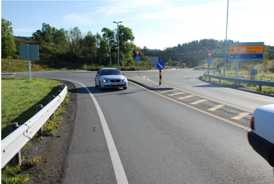
Figur 2.2. Rundkjøring, hvor bilist som skulle mot Oslo, svingte til venstre for sentraløya, og inn på avkjøringsrampe fra motorveien.
