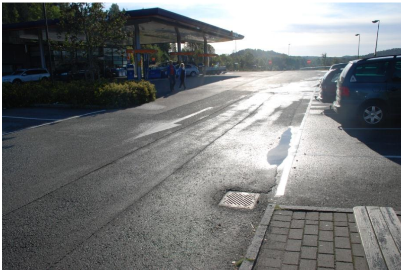
Figur 1.5. Sikt fra parkeringsområde mot munning av avkjøringsrampe fra sør.
