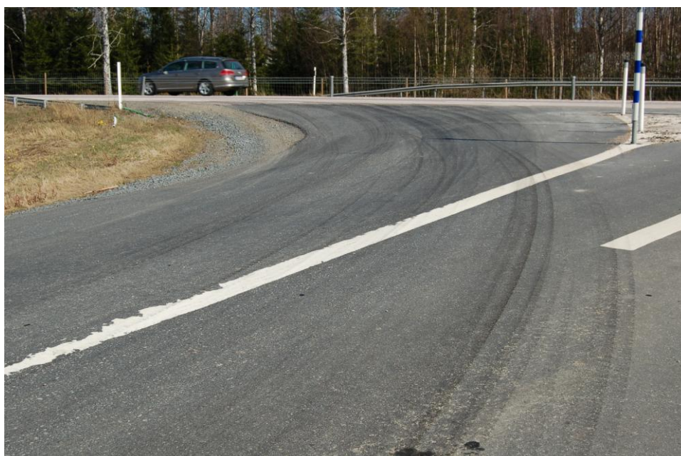
F2.8: Avsvängande tunga fordon från E4 använder båda körfälten på den anslutande vägen.
