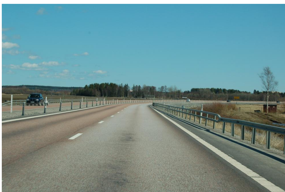
FI.2: Sista delen av raksträckan före S-kurvan. Den breda vägrenen utfasas, vilket markeras med ett stabilt vägräcke. Den minskade vägbredden motiverar att högsta tillåtna hastighet sänks till 90 km/h. Vägmärket med 90 km/h placeras på båda sidorna av vägbanan där utfasningen börjar tillsammans med vägmärket "Avsmalnande väg".
