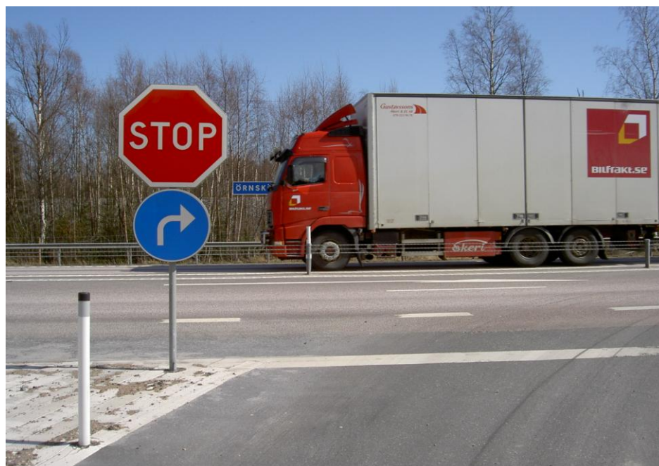
F2.5: Påfarten till E4 har en "rak anslutning", som inte ger någon "naturlig" anvisning om att man skall svänga åt höger.
