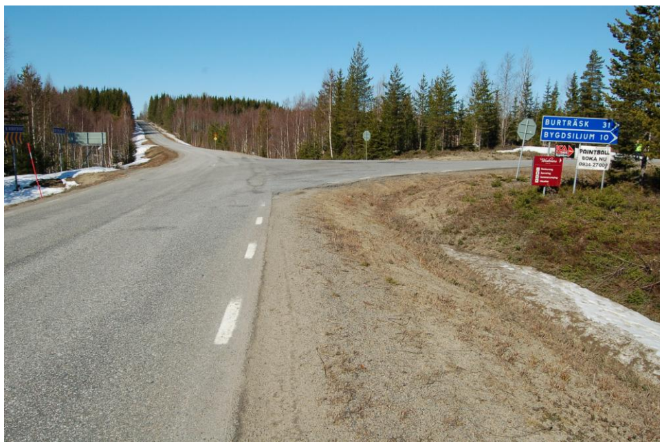
F3.7: T-korsningen sedd från den genomgående vägen. Den anslutande vägen från höger lutar tydligt upp mot krönet.
