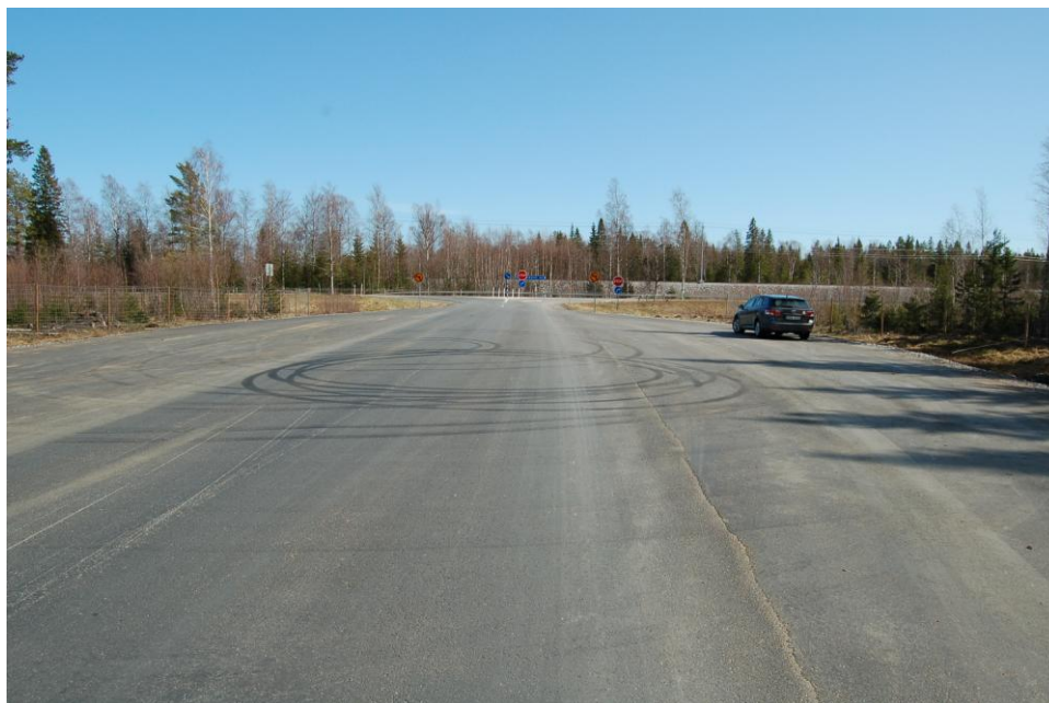
F2.1: Vi närmar oss E4 och ser T-korsningen på avstånd. Lägg märke till den stora vägbredden alldeles före korsningen.
