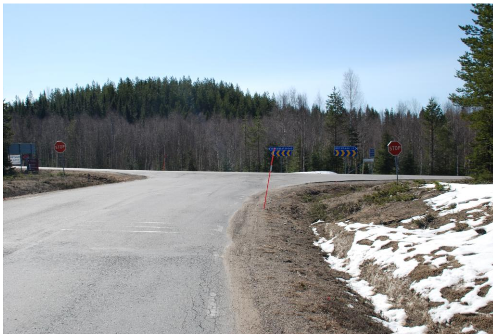
F3.5: På krönet blir föraren överraskad av att korsningen har varit skymd och att avståndet till stopplinjen är så litet.
