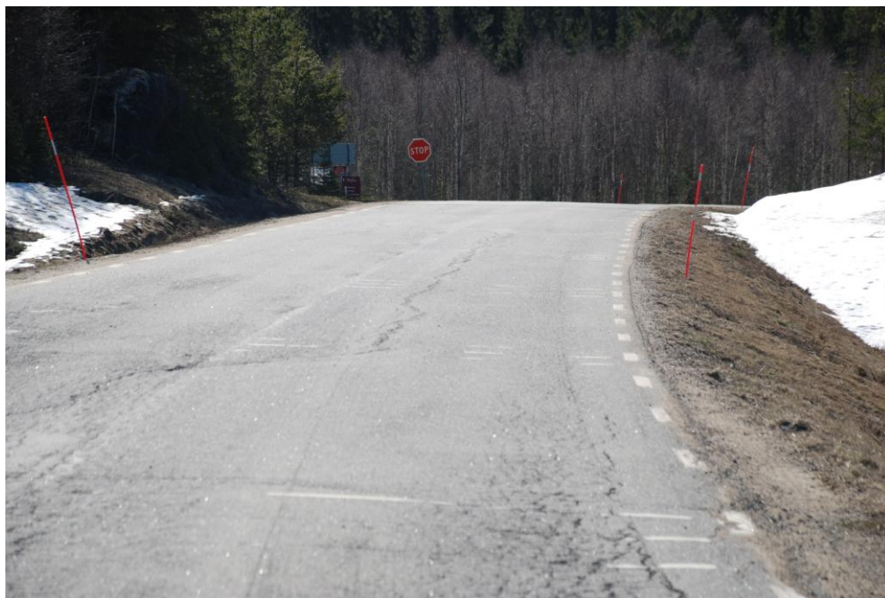
F3.3: Vägen syns fortsätta över krönet i en svag kurva åt höger. Stoppmärket passar inte in i förarens helhetsupplevelse av vägen.
