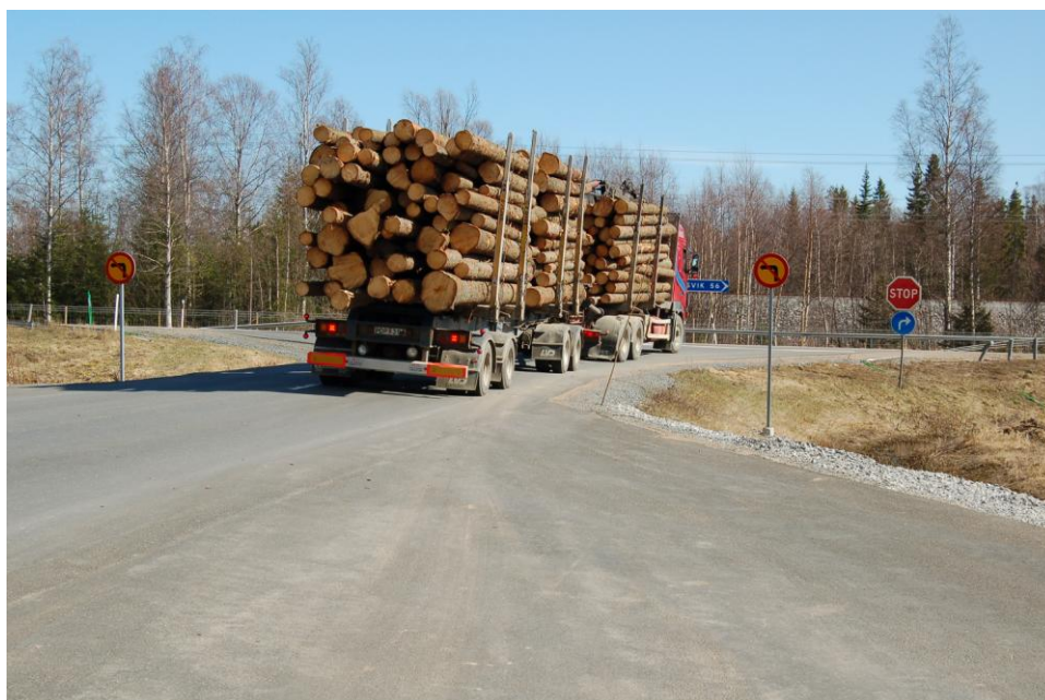
F2.7: Korsningen är inte dimensionerad för tunga och långa fordon.
