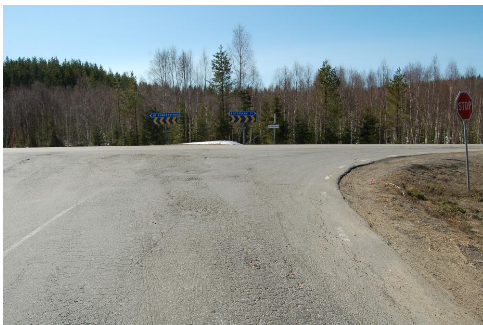
F3.6: Vid halka har bilar inte lyckats stanna utan kört över den genomgående vägen och hamnat i diket mellan de båda bakgrundsskärmarna.
