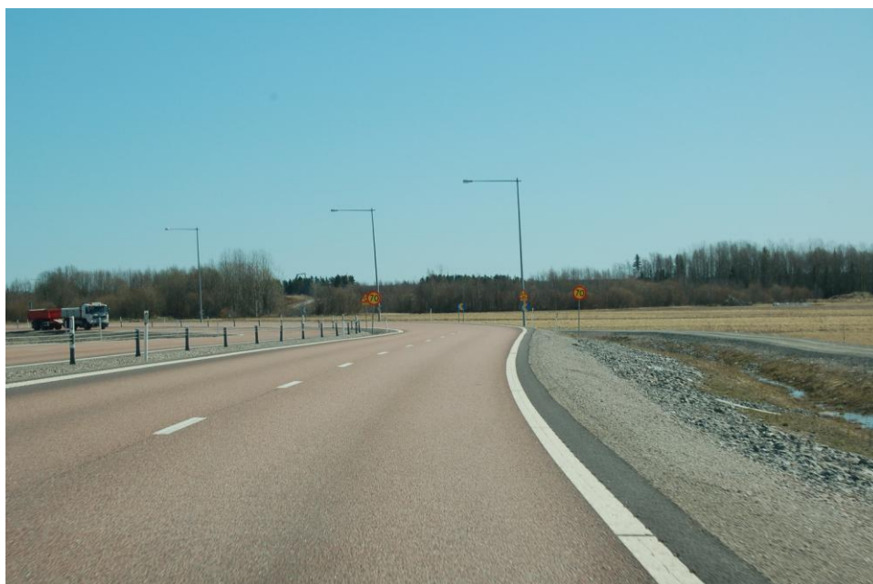
Fl.5: Bilden visar hur första delen av S-kurvan slutar och hur den tvära andra delen av kurvan börjar. Varningmärket för skarp kurva åt vänster flyttas längre från den tvära kurvans början samtidigt med att högsta tillåtna hastighet sänks till 60 km/h. Vägmärkena placeras på samma stolpar på båda sidor av körbanan.
