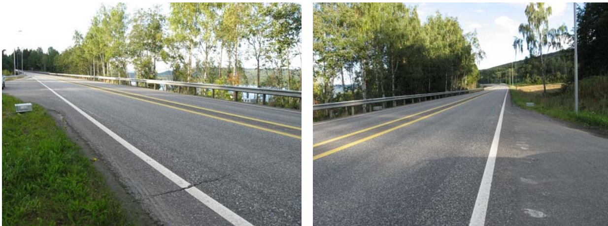
Figur 2.6 Målepunkt på E6 i Oppland (Hp3 km8,2). Forsterket midtoppperking med dobbel plan sperrelinje og sinusriller innenfor vegoppmerkingen.
