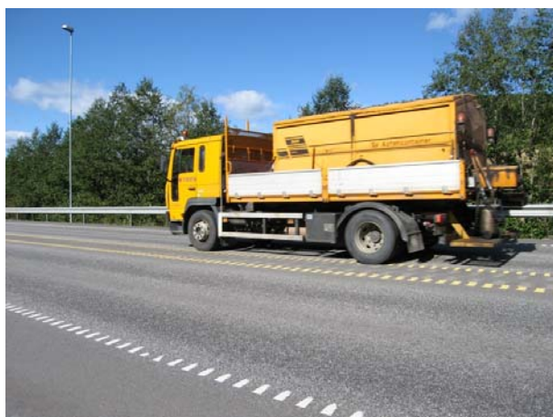
Figur 2.11 Kontrollert overkjøring av profilert vegoppmerking sør for Mjøsbrua (E6 Hp5 km8,5)
