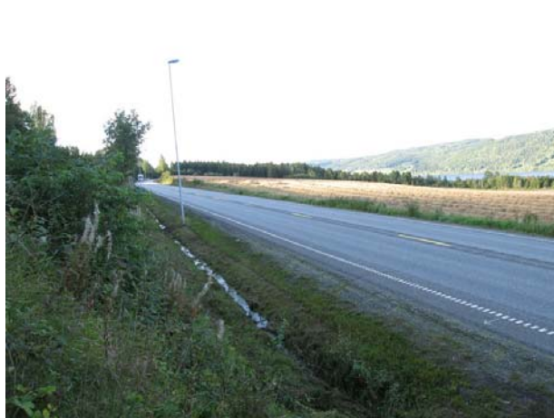
Figur 2.4 Målepunkt på E6 i Oppland (Hp3 km2,6). Forsterket midtoppmerking med plan kjørefeltlinje og sinusriller på begge sider av vegoppmerkingen.
