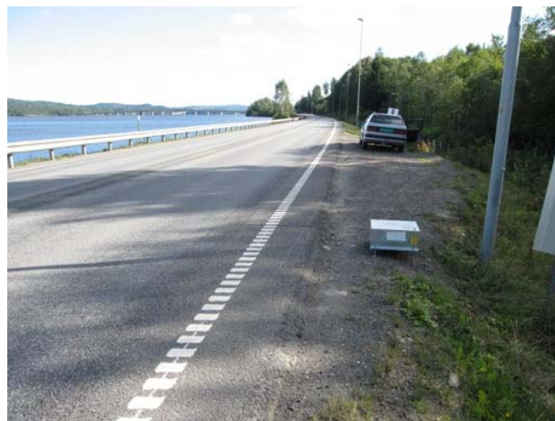
Figur 2.3 Målepunkt på E6 i Oppland (Hp2 km1,0). Forsterket midtoppmerking med profilert kjørefeltlinje og sinusriller på begge sider av vegoppmerkingen.
