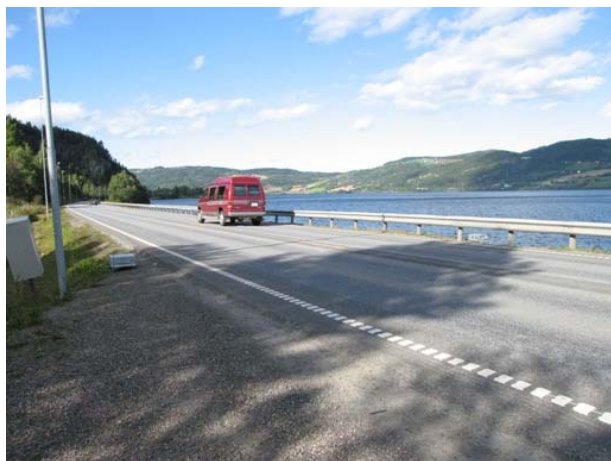
Figur 2.3 Målepunkt på E6 i Oppland (Hp2 km1,0). Forsterket midtoppmerking med profilert kjørefeltlinje og sinusriller på begge sider av vegoppmerkingen.
