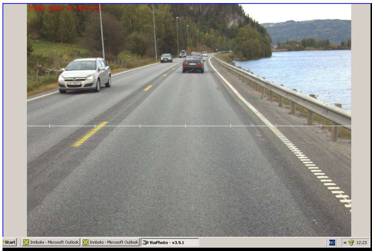
Figur 1.4 Forsterket midtoppmerking med profilert kjørefeltlinje og sinusriller utenfor vegoppmerkingen
