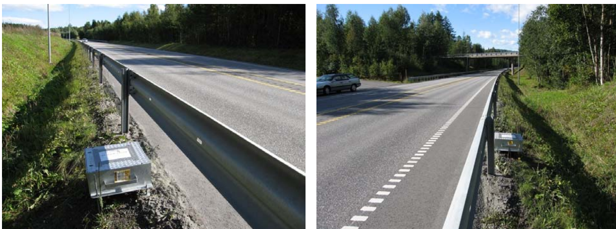
Figur 2.1 Målepunkt på E6 i Hedmark (Hp5 km10,55). Forsterket midtoppmerking med dobbel profilert sperrelinje og rumleriller innenfor vegoppmerkingen.
