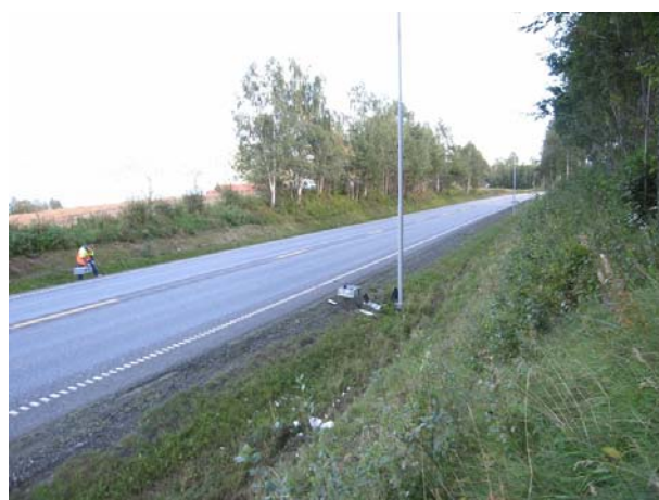
Figur 2.4 Målepunkt på E6 i Oppland (Hp3 km2,6). Forsterket midtoppmerking med plan kjørefeltlinje og sinusriller på begge sider av vegoppmerkingen.
