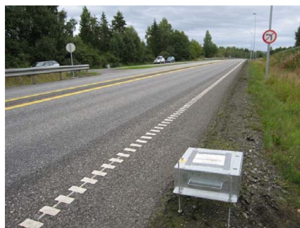
Figur 2.5 Målepunkt på E6 i Oppland (Hp3 km3,8). Forsterket midtoppmerking med dobbel plan sperrelinje og sinusriller innenfor vegoppmerkingen.
