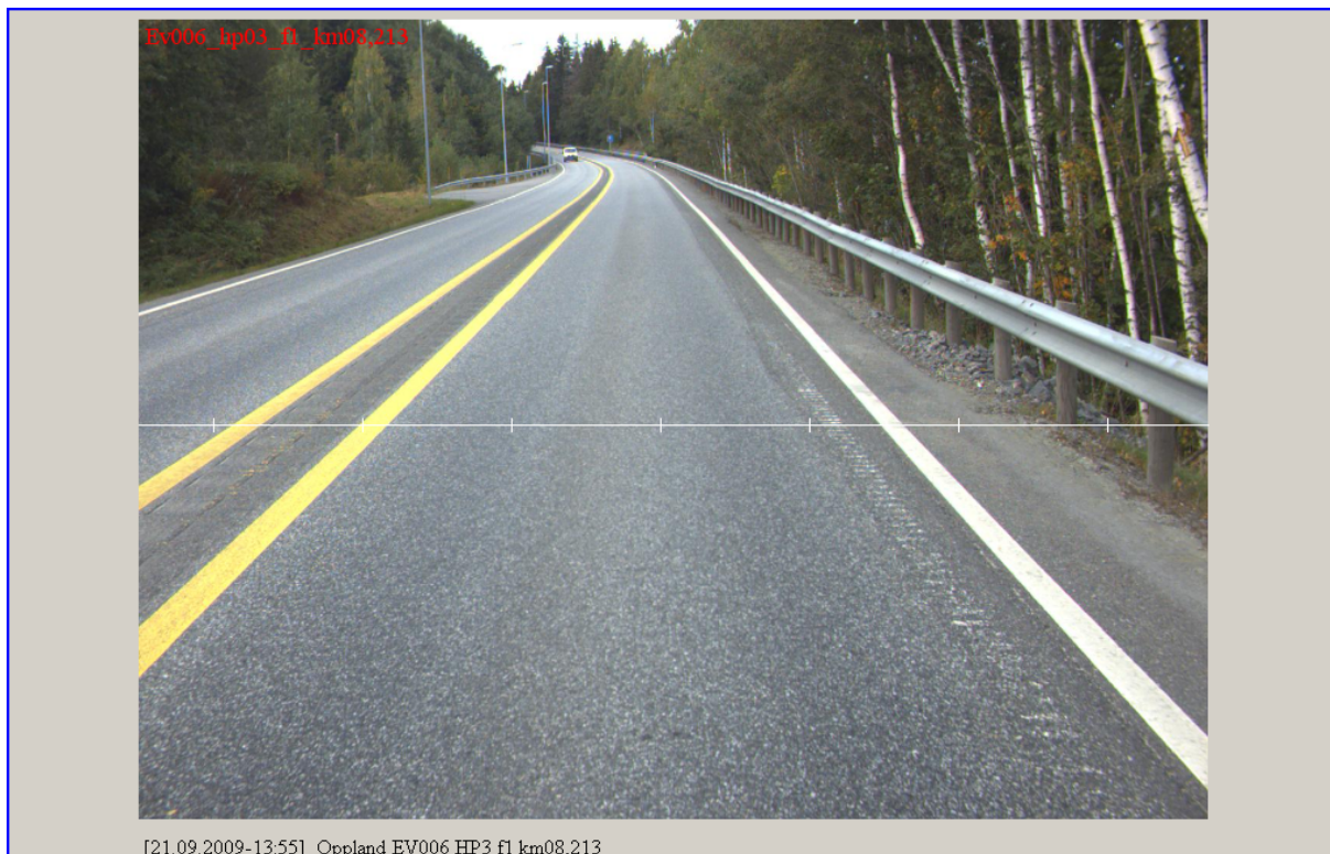
Figur 1.3 Forsterket midtoppmerking med dobbel plan sperrelinje c/c 1,0 meter med sinusriller innenfor vegoppmerkingen
