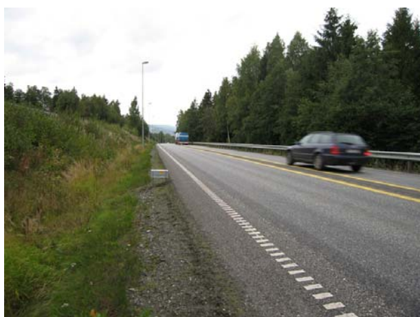
Figur 2.5 Målepunkt på E6 i Oppland (Hp3 km3,8). Forsterket midtoppmerking med dobbel plan sperrelinje og sinusriller innenfor vegoppmerkingen.
